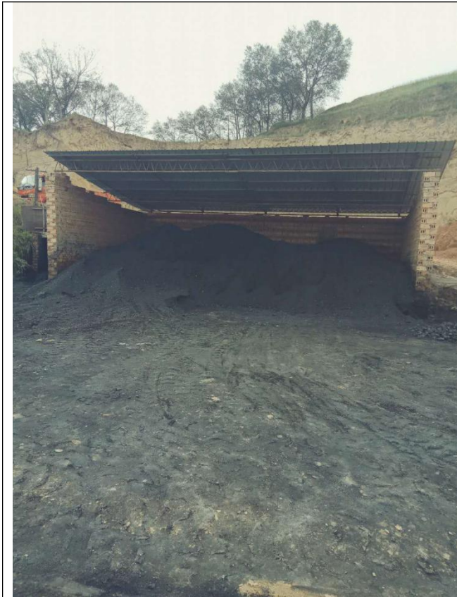
半封闭式储煤棚
