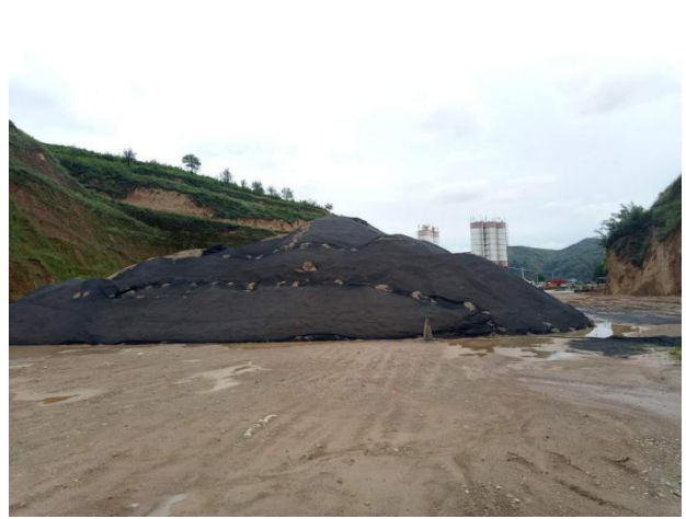
原料覆盖抑尘网堆放
