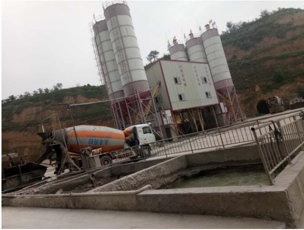
洗车废水沉淀池
